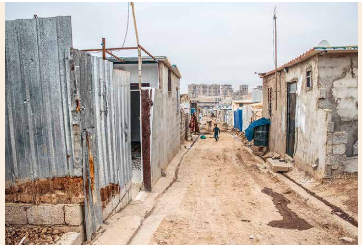
Über die Jahre wurden in dem Flüchtlingslager Zelte durch einfache Betonhäuser ersetzt.
